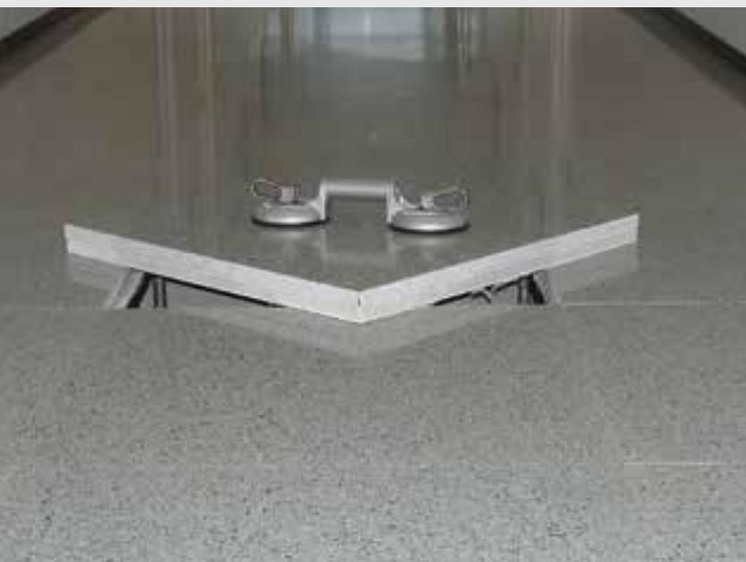
Struttura portante in acciaio zincato costituita da supporti verticali con base di appoggio, barra filettata, tubo distanziale e testa stampata e nervata per permettere l'aggancio di travi a sezione omega su di una elevata area di sovrapposizione ed aderenza, mediante incastro a scatto di elevata rigidità.
